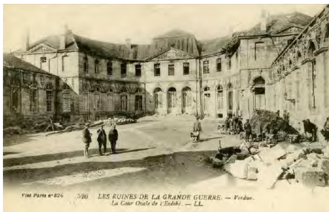
Travaux de reconstruction dans la cour du palais épiscopal. (Coll. Mémorial de Verdun)
