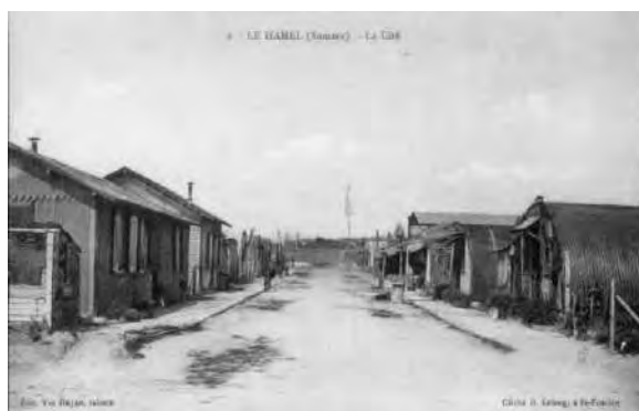
Rue à Le Hamel mêlant baraques Adrian et Nissen. © Archives départementales de la Somme
