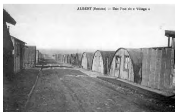
Baraques provisoires Nissen et Adrian à Albert © Archives départementales de la Somme
