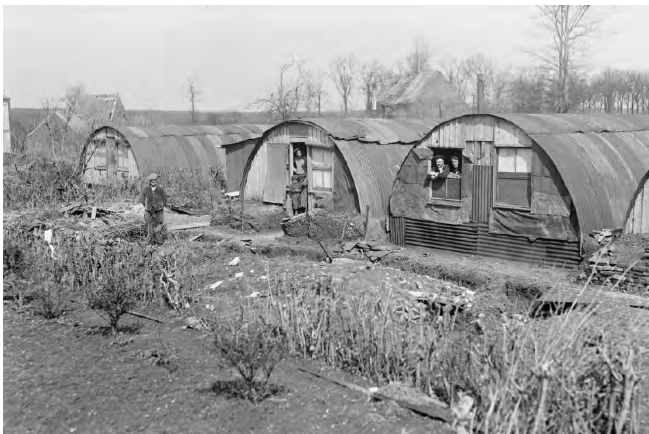
Baraques provisoires Nissen à Equancourt, 13 avril 1919.
