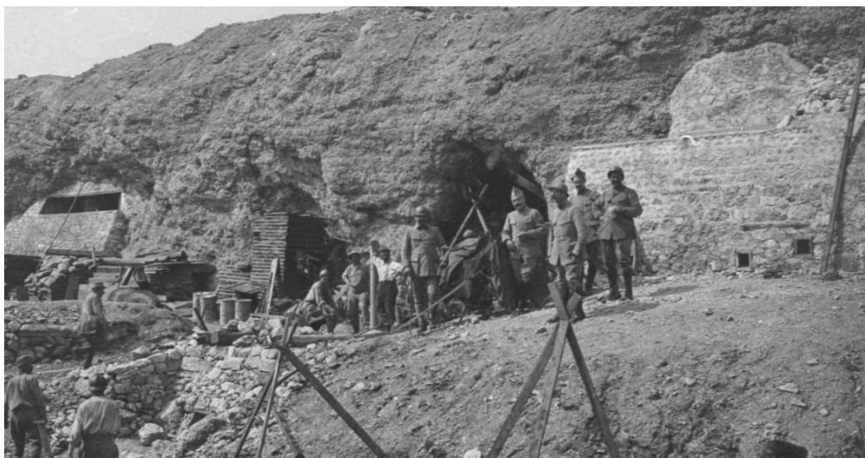
Entrée du Fort de Vaux, vue extérieure, 11 juin 1917 © La Contemporaine
