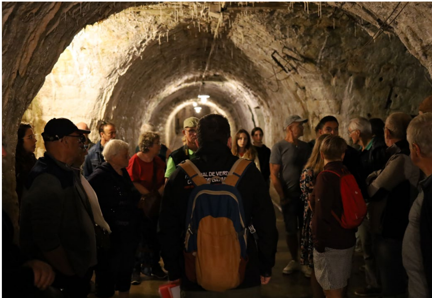
Galerie intérieure du fort de Douaumont.
