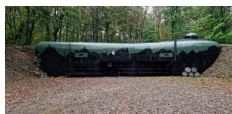
Ligne Maginot : Entrée de l'ouvrage du bois de Bousse © Jean-Luc Kaluzko
